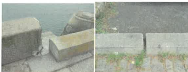
Figure 51: Murets bassin du commerce : discontinus et de faible hauteur
