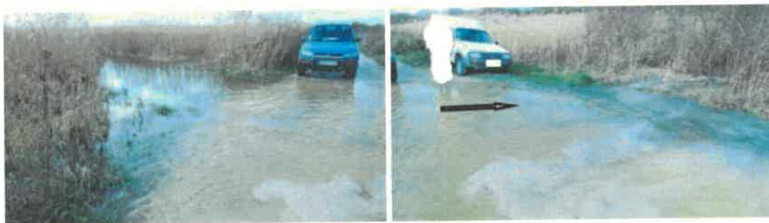
Figure 52: Surverse constatée le 31 décembre 2013 au niveau du tronçon 5 de la digue
